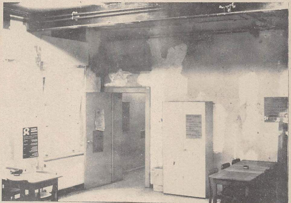
Folgen einer Umbauzeit Dez 78 - ???
