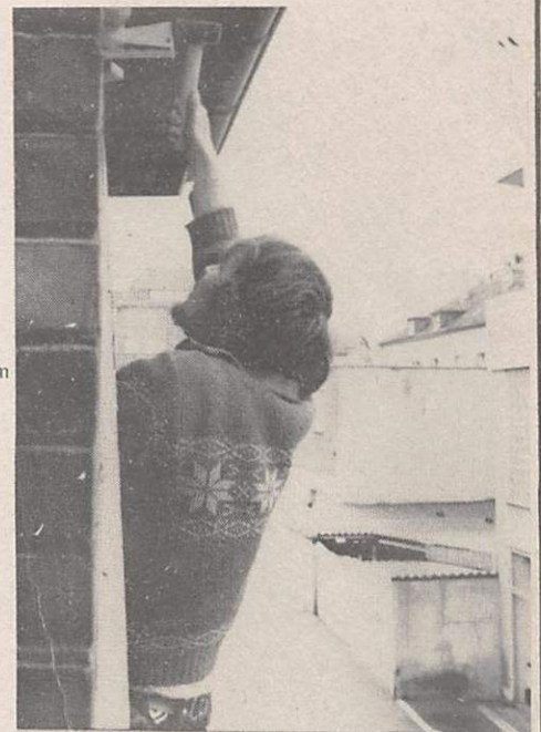
Ernst repariert die Fenster im 1. Stock.
