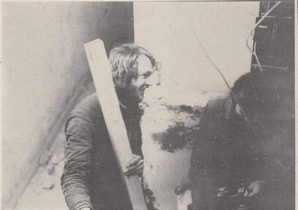
Stefan und Norbert, beim Anschluß des neuen Sicherungskastens.
