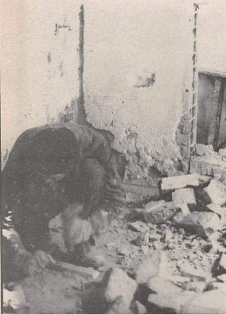
Zwecks Recycling klopft der Wolfgang alten Mörtel von den Steinen ab.
