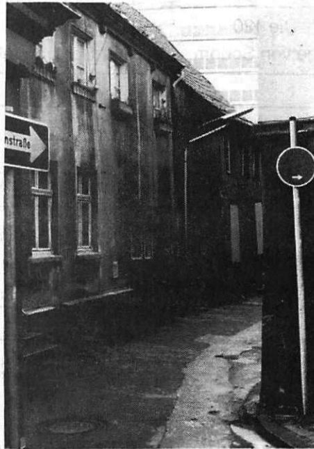
Werden abgerissen: die Häuser Wiethofstr. 3 und 5
