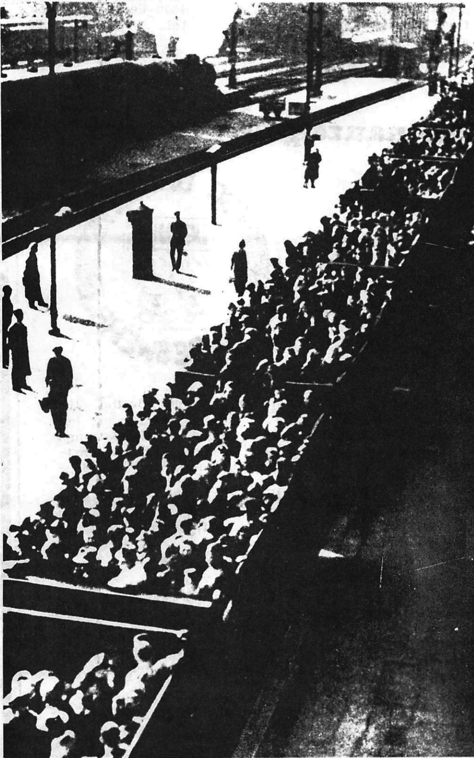
Reichsbahntransporte in Ghettos- und Vernichtungslager
