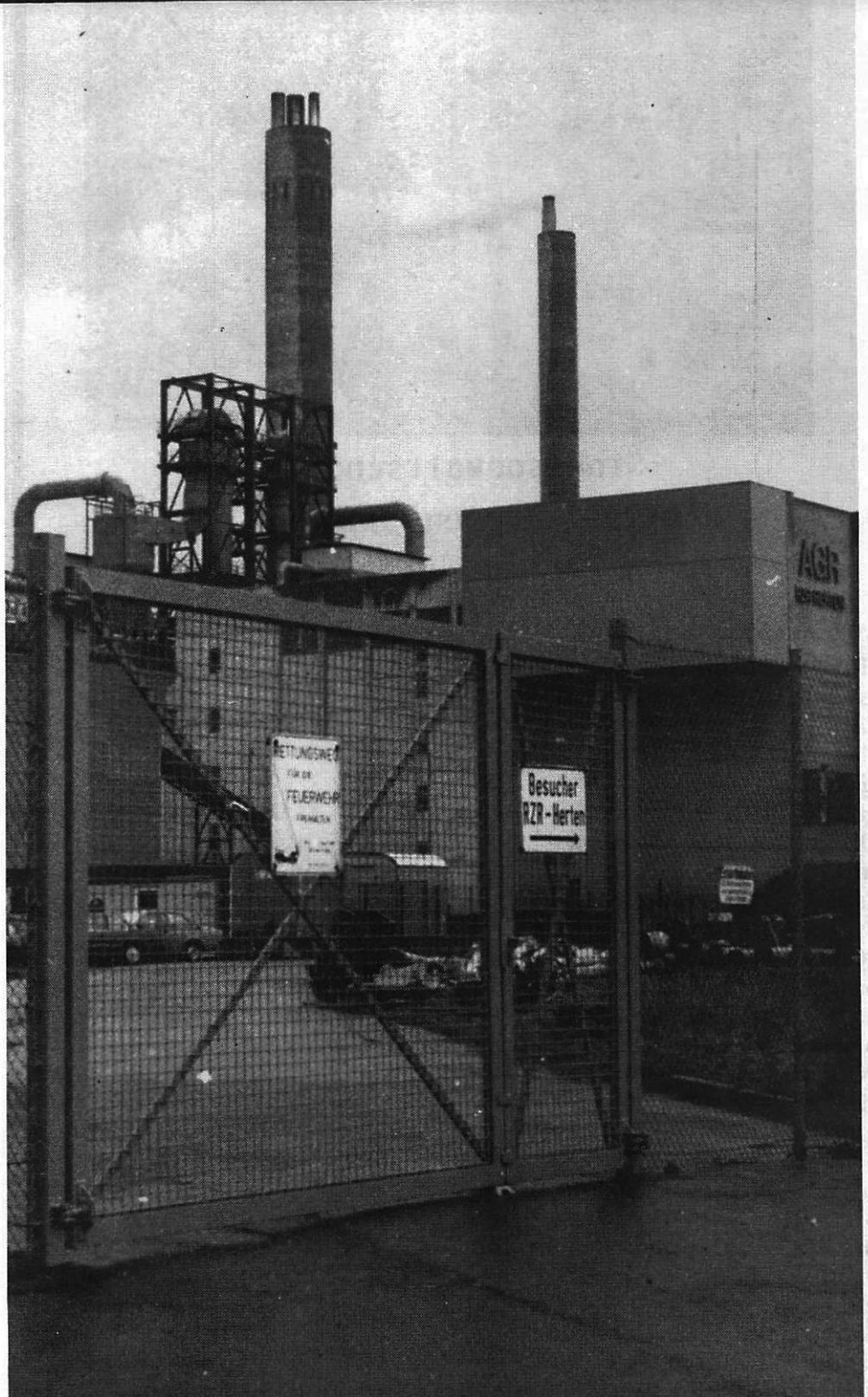
hier im RZR in Herten sollen PCB-haltige Abfälle verbrannt werden
