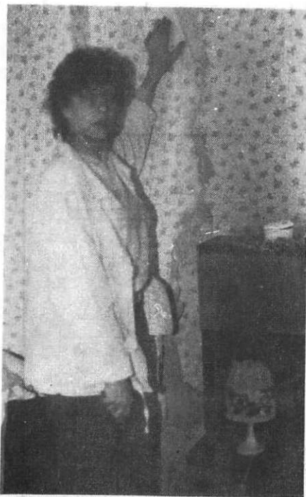
Risse in den Wänden
