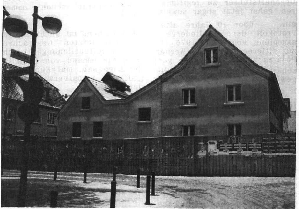
Altstadtschmiede während des Umbaus
