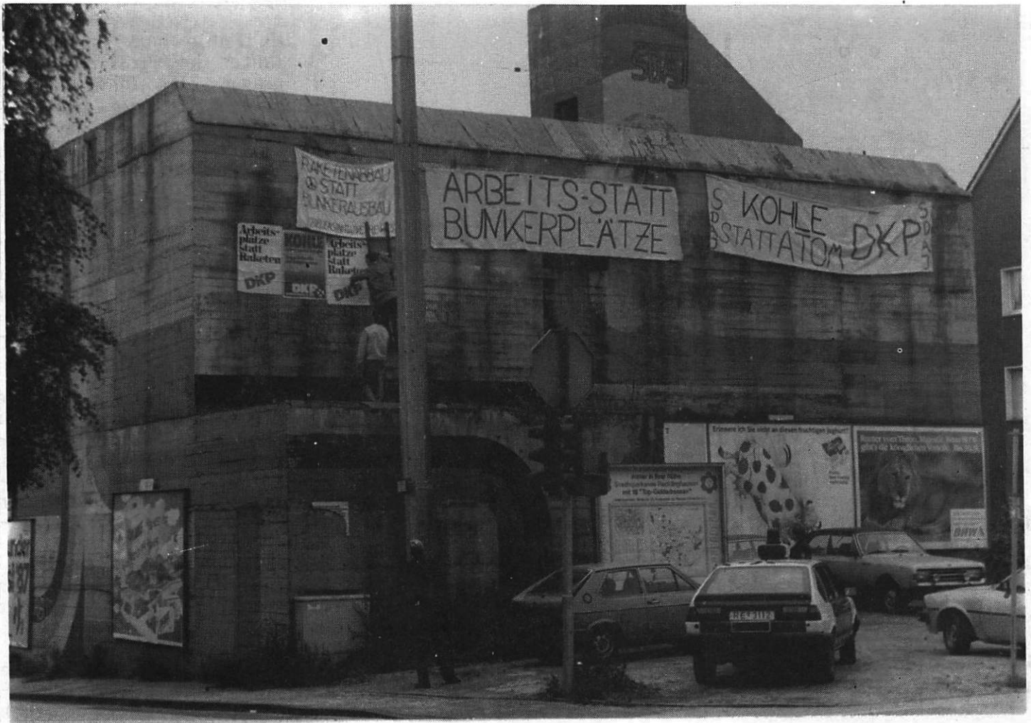
Bunker an der Hertener Straße
